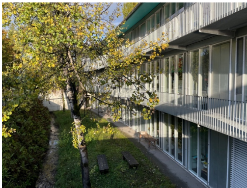
Tiefhof «Neues Schulhaus»
